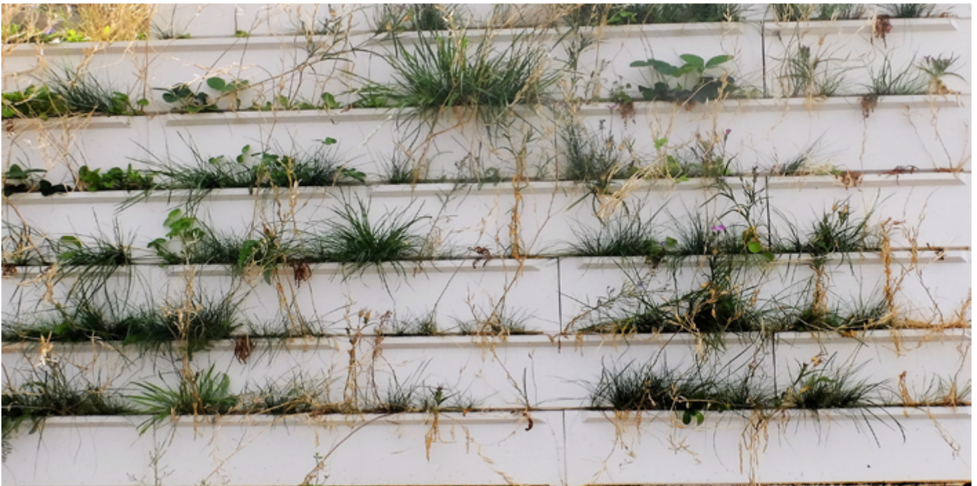
Système de végétalisation verticale par empilement de modules composés de matériaux recyclés
