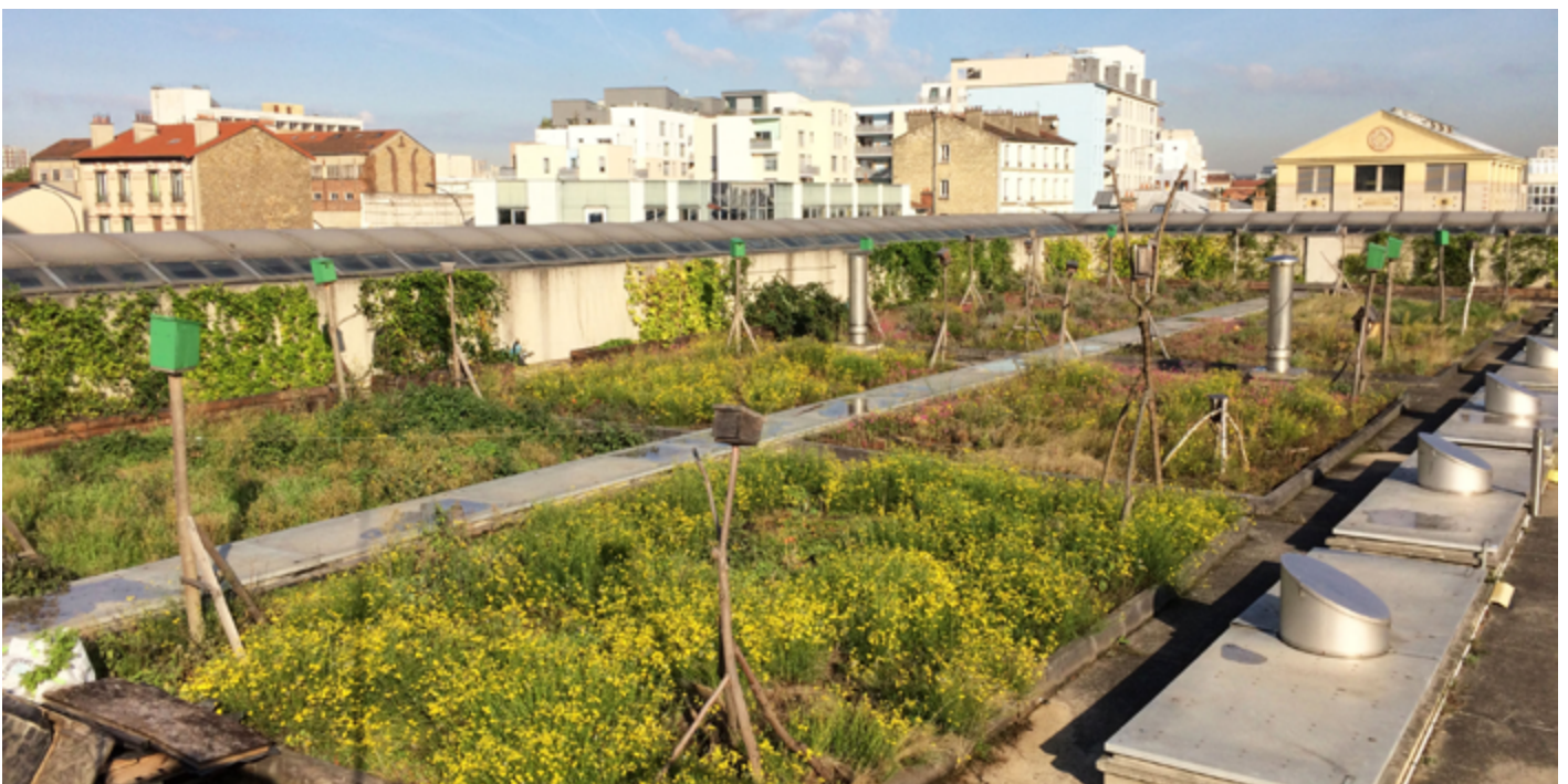
Vue générale de l'expérimentation WildRoof après 2 ans d'installation sur le site
