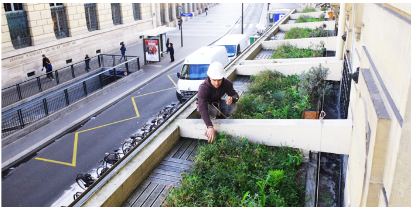
Graminées, plantes à bulbes et aromatiques vivaces constituent la palette végétale de cette toiture végétalisée très faible épaisseur
