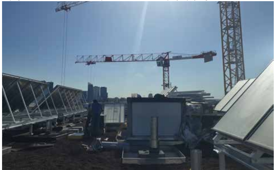
Chantier en cours, végétalisation des toitures - juillet 2020
